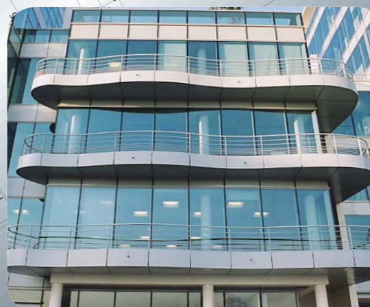
Garde-corps, passerelles, escaliers Immeuble M11 bord de Seine - Paris
