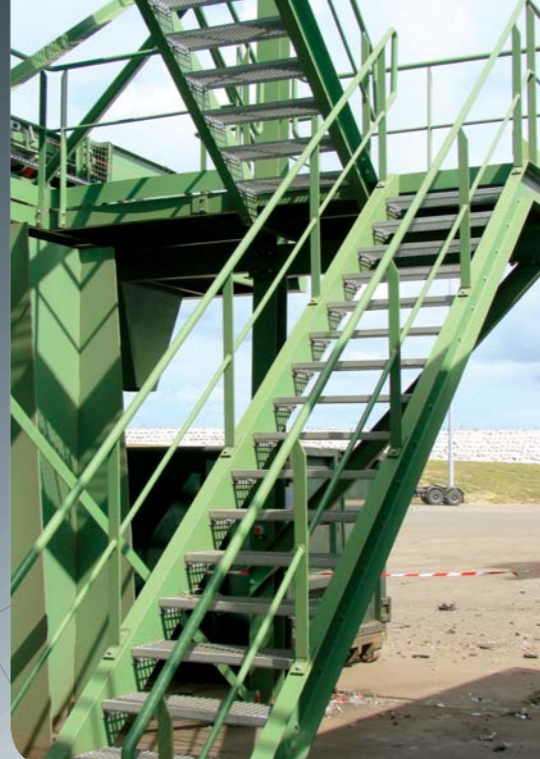
Ensembles d'accès machines GDE - Saint-Nazaire
